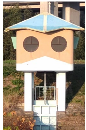
▲河童の頭がモチーフにされた永島排水樋管(はいすいひかん)
